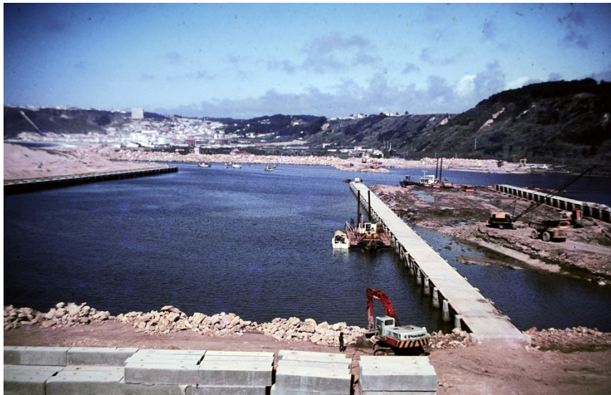
Construção do Porto da Nazaré. Fonte: Carlos Hipólito
